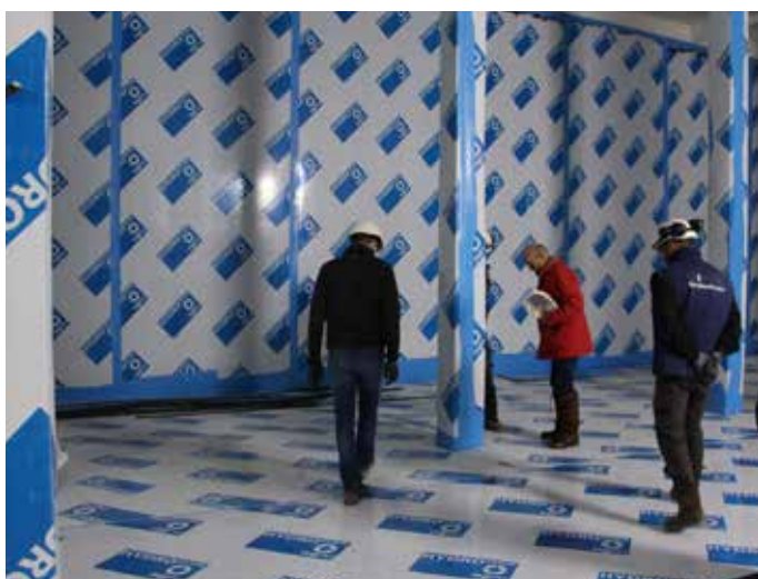
Visite des élus intercommunaux du chantier de réhabilitation de cuves d'eau potable • Novembre • Deauville
